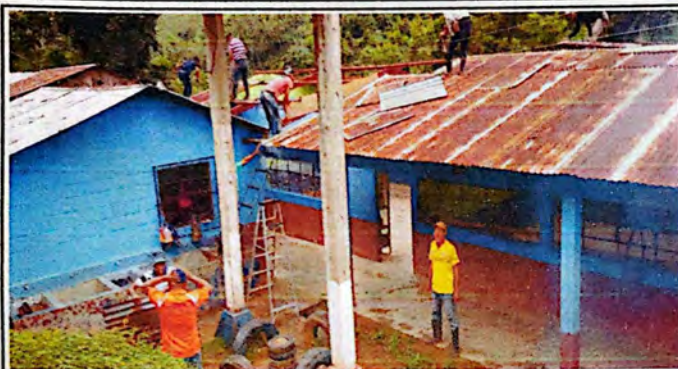
En esta imagen se observa cuando se empieza a quitar las láminas deterioradas y el desarme de la estructura de madera.
