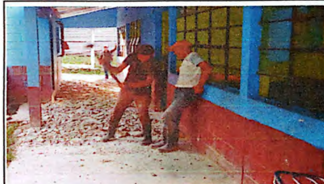
En esta imagen se ve el cambio de piso del corredor que por estar deteriorado es necesario reemplazarlo.
