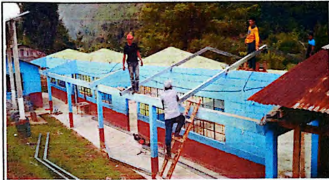
Acá se observa el cambio de la estructura de madera por estructura de metal.
